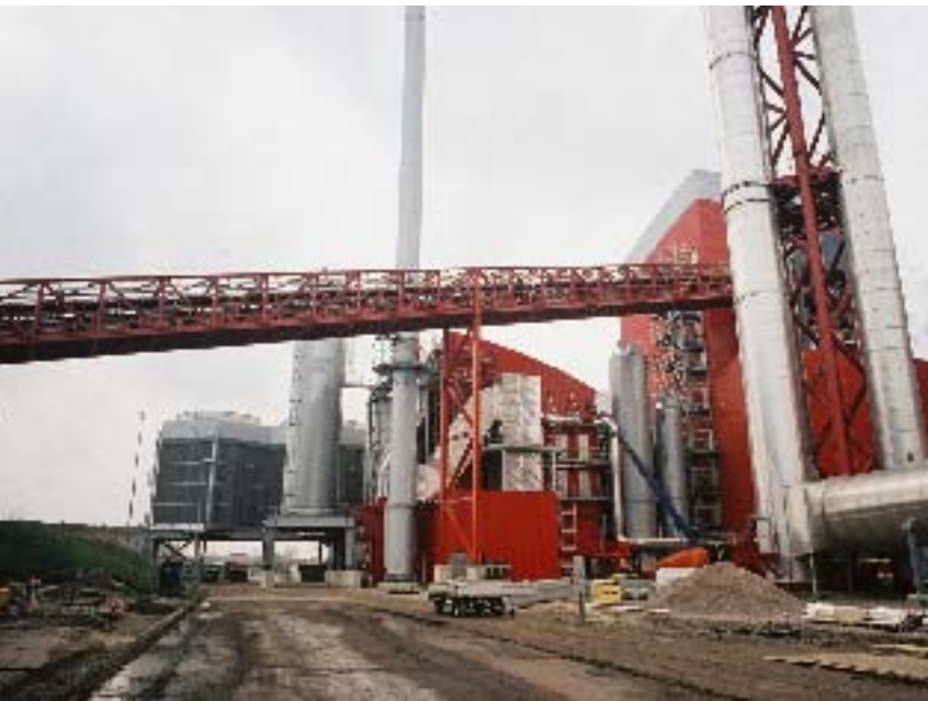
2,5 MW van de opgewekte stroom gebruikt HVC zelf, 22,5 MW gaat naar het net
