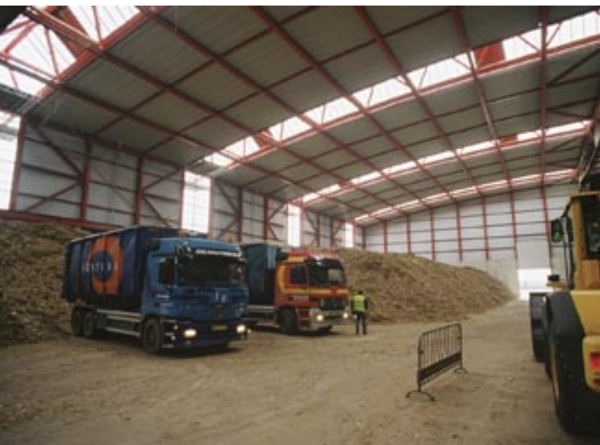
De opslagloods kan voor vijf dagen brandstof opslaan, jaarlijks verdwijnt zo'n 200.000 ton afvalhout
